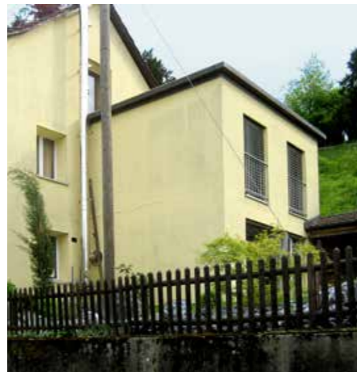
Der westliche Anbau ist der ehemalige Operationsaal
