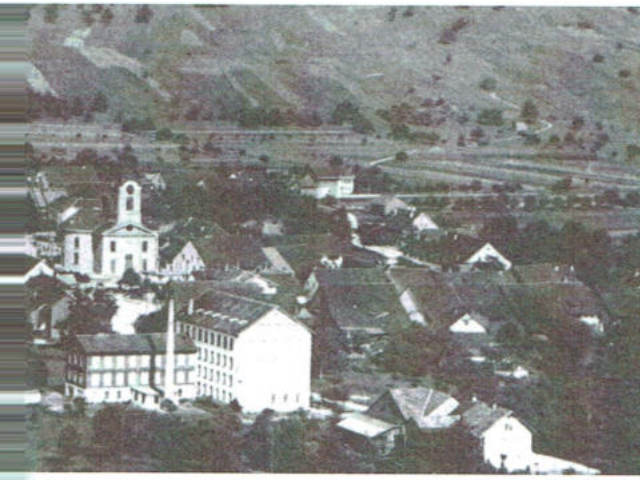
Oberer Dorfteil mit Trafostation.
