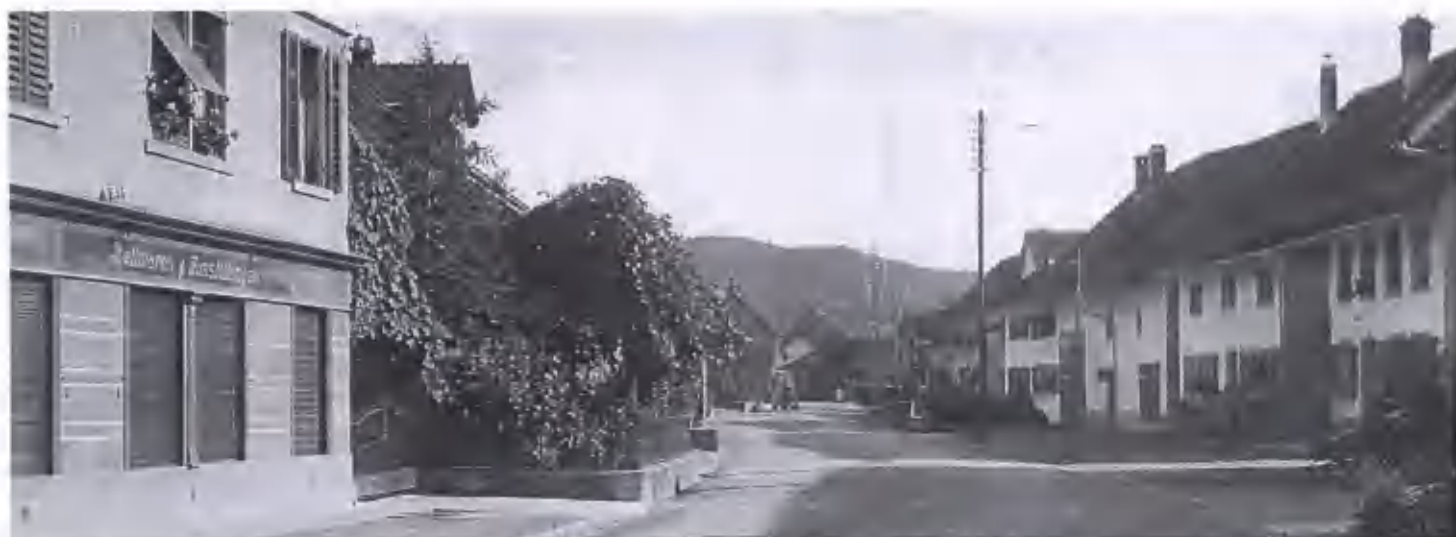
Die Hintergasse um 1930. Kinder hatten immer noch Platz zum Spielen; der Verkehr war noch sehr bescheiden. Direkt grossstädtisch das Gewirr von Telefonleitungen, zum Teil auf Gittermasten. Rechts der Telefonstange im Vordergrund eine Strassenlampe und links ein Brunnen ohne Strassenlampe auf dem Stock. Sammlung Dünki
