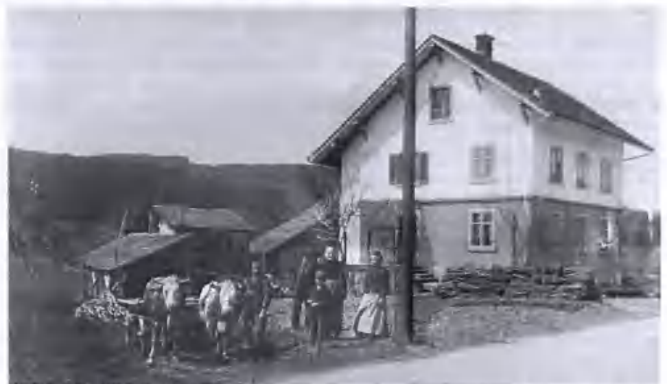
Die Station Bächli stand zu der Zeit schon, nur wer fotografierte schon eine Trafostation. Sie wäre im nach 1907 aufgenommenen Bild links zu sehen. Das Bild zeigt das Haus Stationsstrasse 9. Bild Hächler
