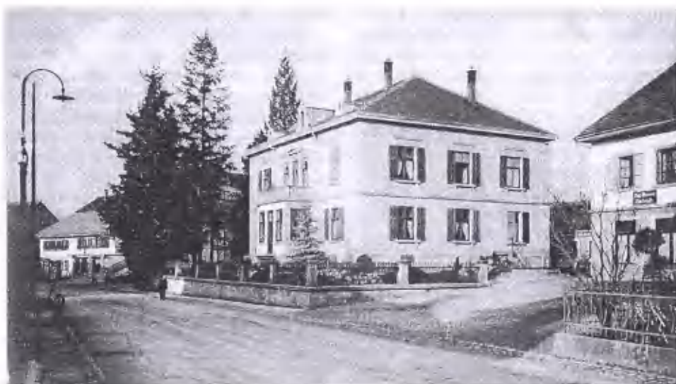
Nochmals die gleiche Lampe, diesmal in ihrer Umgebung von alter Post und Villa Ganz. Gut sichtbar der Aufsatz für die Elektrifizierung von 1904. Archiv Baer
