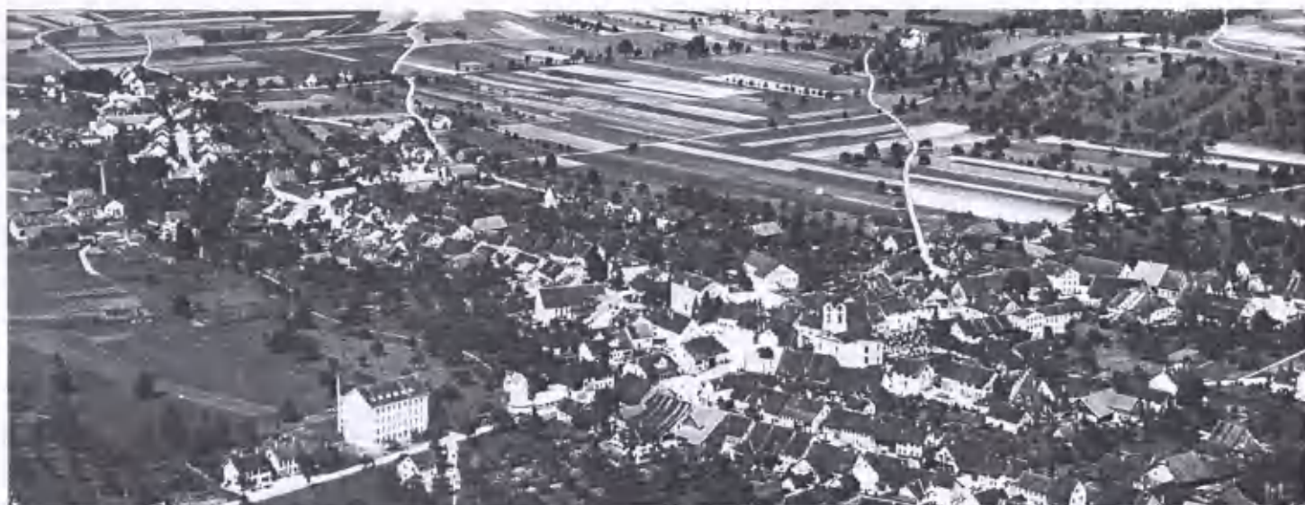
Embrach um 1932, an und für sich keine spezielle Luftaufnahme, wenn da nicht die beiden Trafostationen an der Winklerstrasse, die Nr. 1 etwas versteckt hinter der Nr. 2 abgelichtet worden wären. Vor und neben der Station scheint sich ein Rummelplatz zu befinden. Die Station Mitteldorf wäre, wenn sie schon gestanden hätte, hinter Bäumen und Häusern versteckt. Sammlung Dünki
