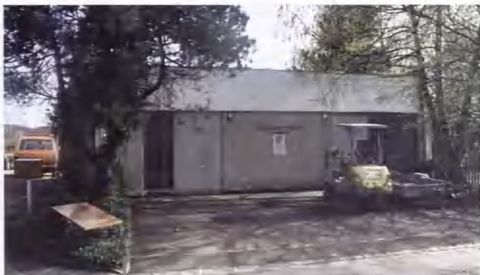
Hier eine Vertreterin der neueren Stationen, diejenige an der Langackerstrasse. Im Gebäude befindet sich nach wie vor eine Pumpstation der Wasserversorgung. Foto Mutti
