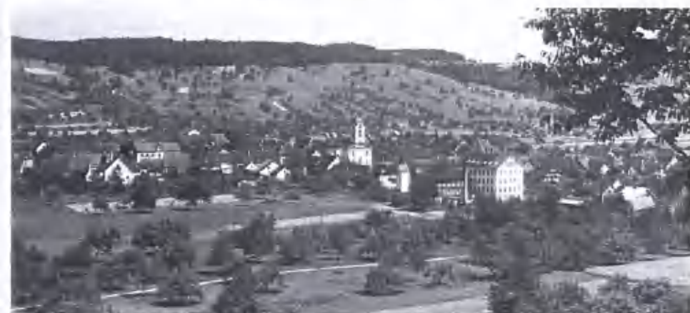
Der obere Dorfteil nach 1932 mit der Trafostation Nr. 2 an der Winklerstrasse. Archiv Dünki
