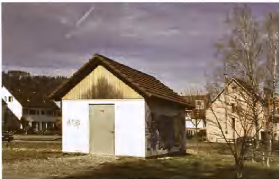
Die dritte Trafostation an der Winklerstrasse. Foto Mutti
