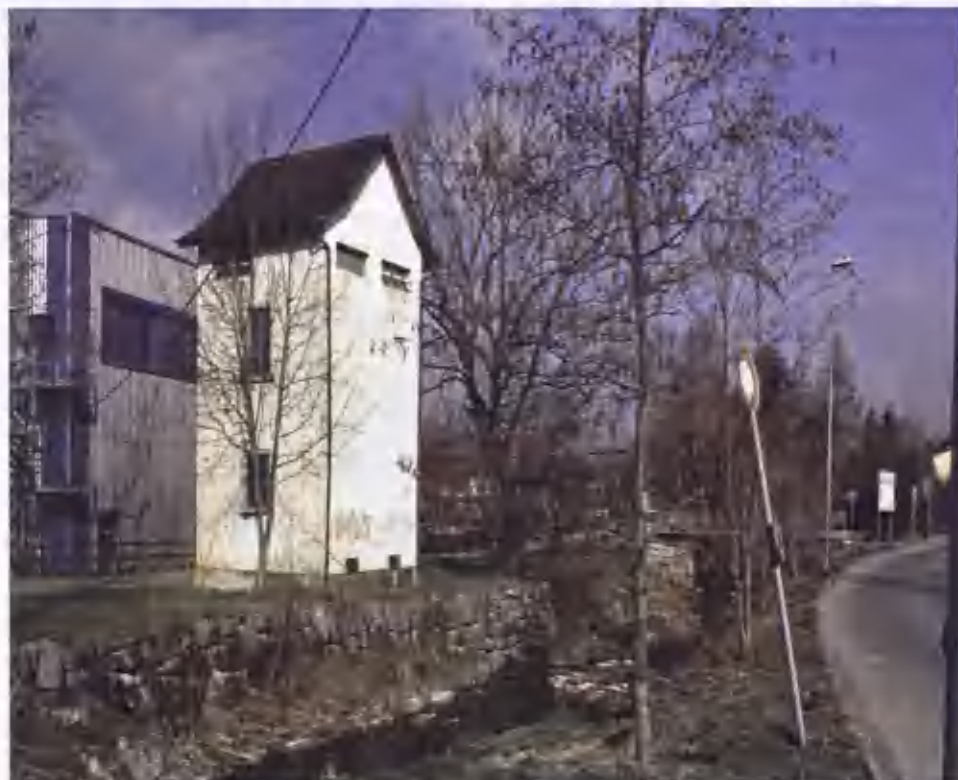
Die 1949 errichtete Mess- und Schaltstation Obermühle. Wie das Bild zeigt, ist sie zwar noch vorhanden, hat aber keine Funktion mehr. Bei ihren Fenstern liess man die Fensterläden weg. Foto Mutti
