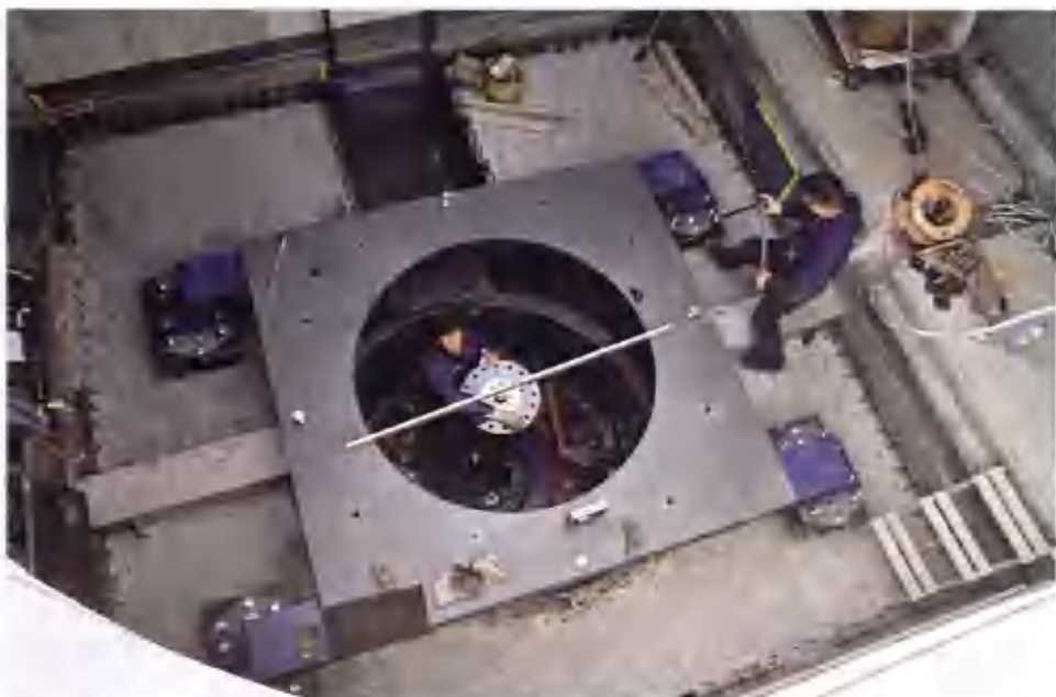
Innereien des neuesten Kindes des EWE: Im Maschinenraum vor dem Einsetzen des Generators. Darunter sichtbar Teile der Turbine. Foto Mutti
