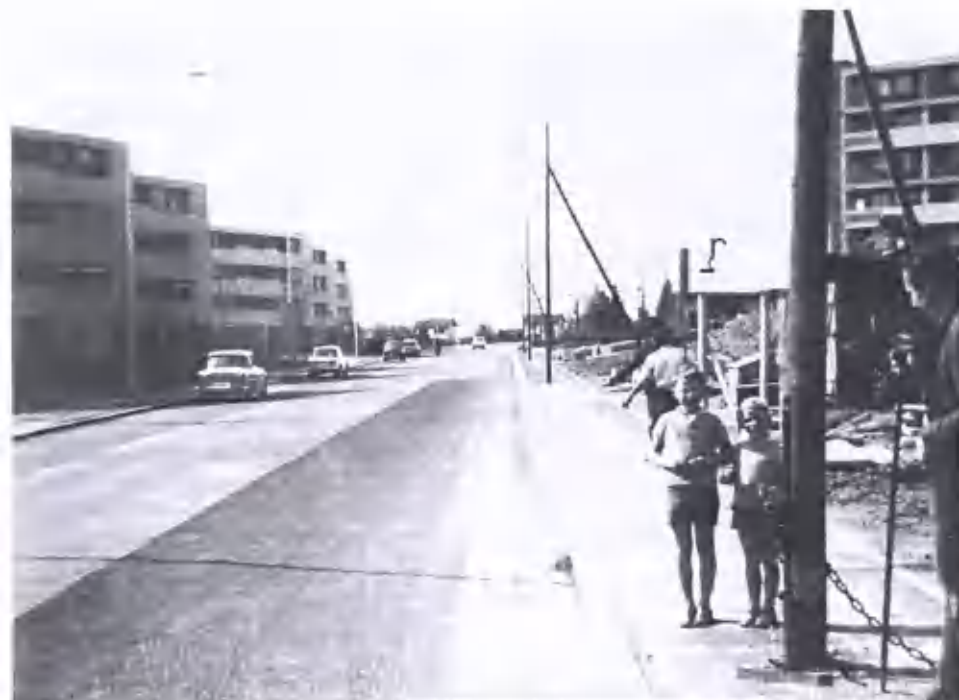
Eine Reminiszenz aus dem Jahre 1963. Stangenstellen für die neue Strassenbeleuchtung nach dem Verlegen des neuen Primärkabels, Korrektur der Strasse und Siedlung SILU im Bau. Bild Peter Menzi
