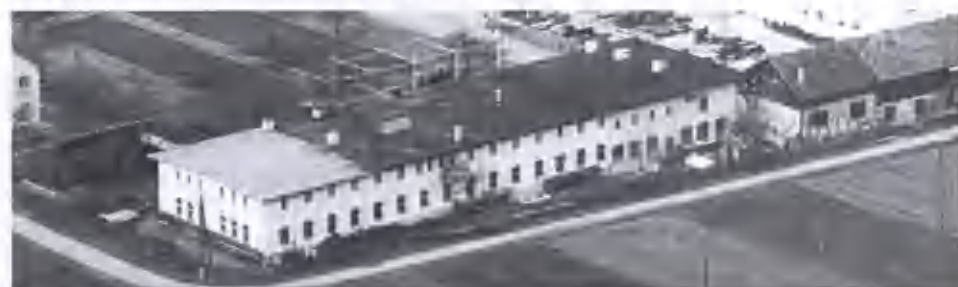
Auf dieser Vergrösserung aus einer Flugaufnahme um 1950 kann man anhand des obenstehenden Planes den Eingang der Station sehen. Links im Bild eines der beiden inzwischen auch abgerissenen Personalhäuser. Archiv Robert Stanger
