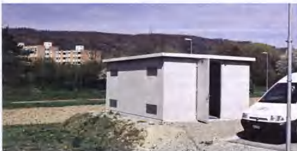
Hier im Bild die neueste Trafostation des EWE, die Station Hard-Nord, wenn man mal vom Neubau der Station Bloch Brandeis absieht. Im Hintergrund das Personalhaus der Klinik Hard. Foto Mutti
