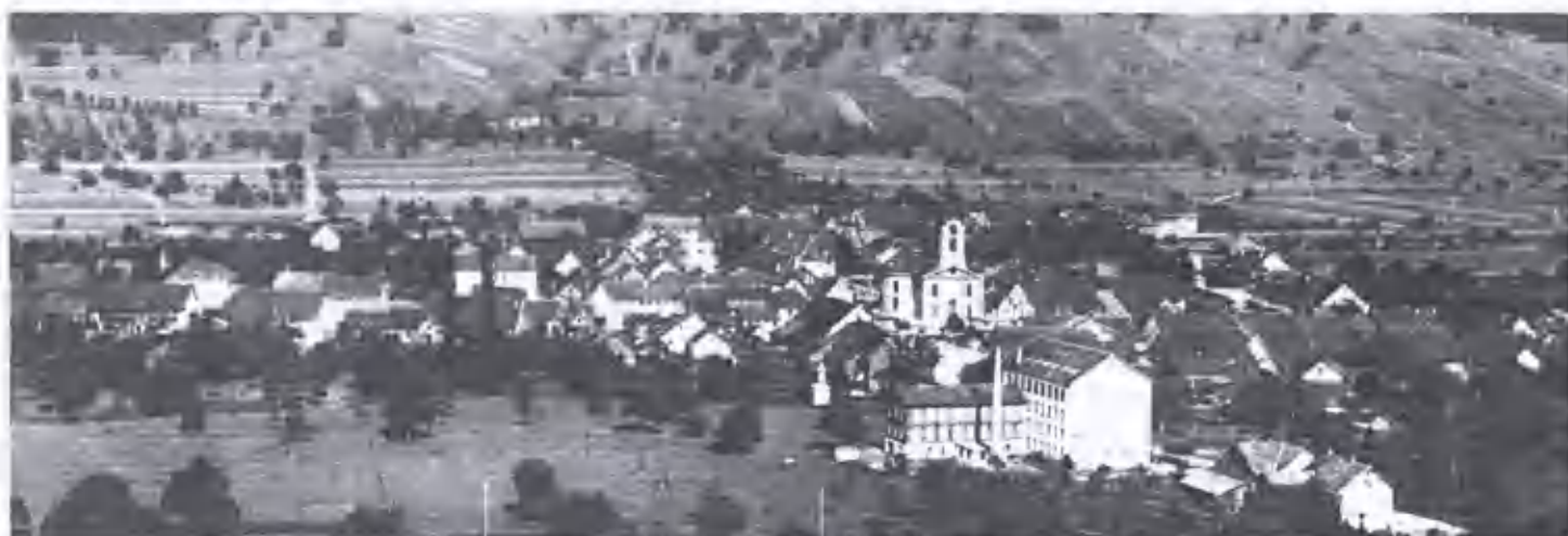
Der obere Dorfteil um 1915. Deutlich sichtbar die Trafostation und deren Standort. Archiv Baer
