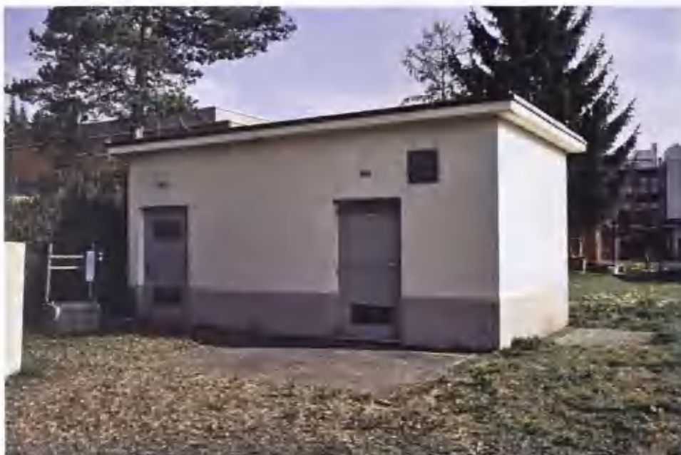
Die Station Bahnhof Süd oder Ebnet oder heute Stationsstrasse im jetzigen Zustand. Foto Mutti
