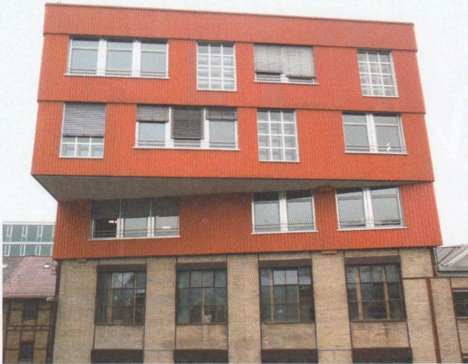
Ein Leuchtturm für nachhaltiges Bauen: Das Projekt K. 118 in Winterthur.
